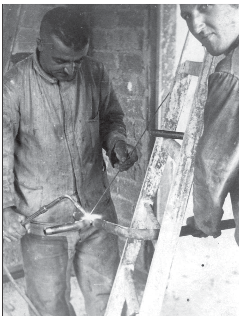
Firmengründer Eugen Seibold (links) bei der Installation der Heizung auf der Tübinger Hütte im Montafon. Bild: Seibold
